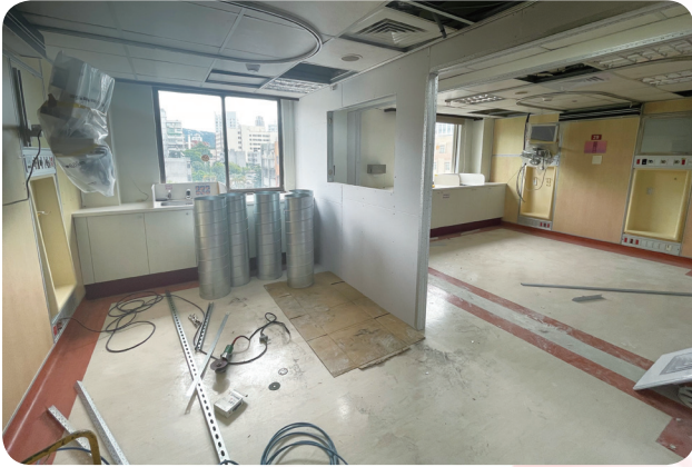
▲專責重症病房施工現場
